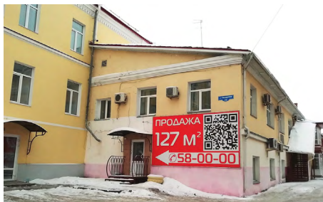
Фото 1. Фасад здания по адресу ул. Гагарина, 20.
